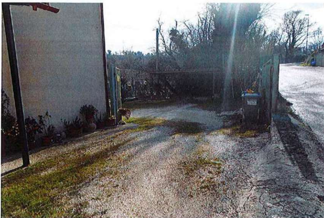
Particolare accesso carrabile dalla via pubblica e rata di terreno lato sud
