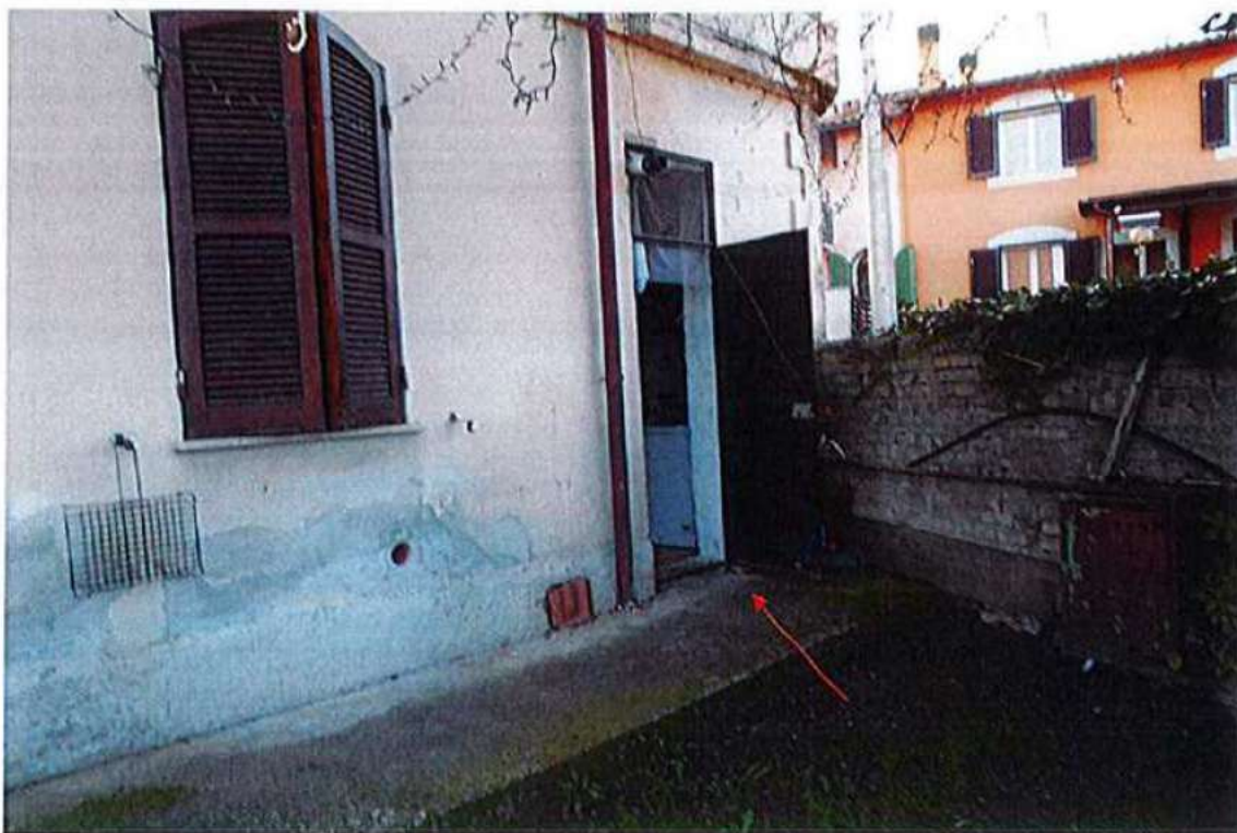
Accesso al locale C.T. dal giardino nord
