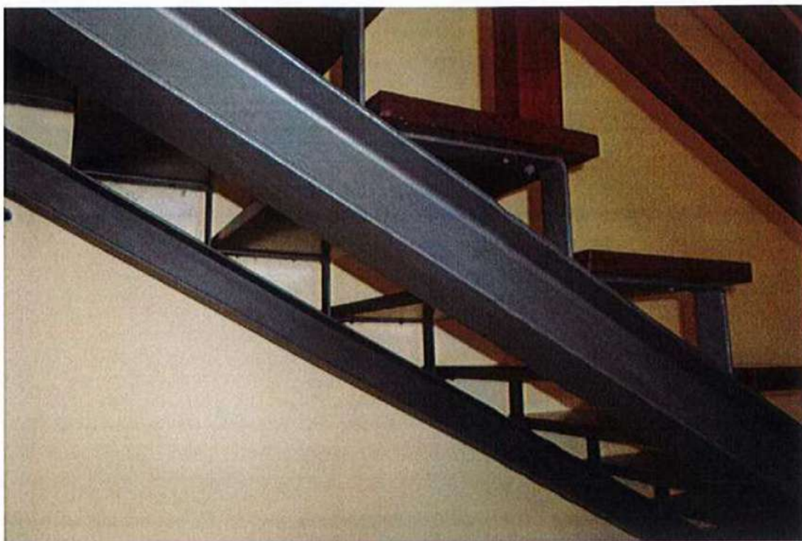
Particolare costruttivo scala
